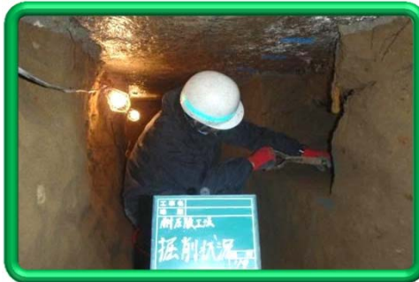
ジャッキ設置場所まで掘削
