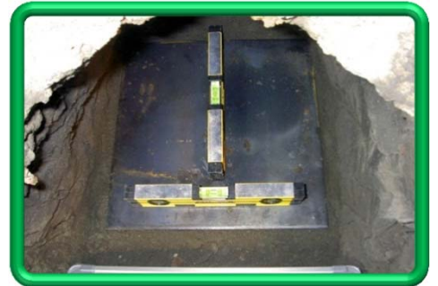
耐圧版を設置し、耐圧版の水平を を確認する
