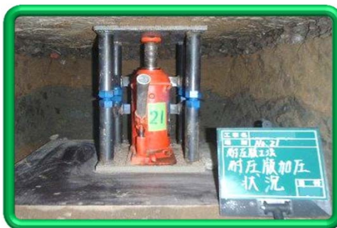
ジャッキアップ状況
