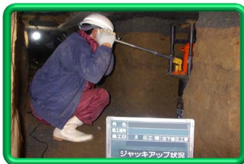
鋼管にアジャスターとジャッキを セットし、ジャッキアップ
