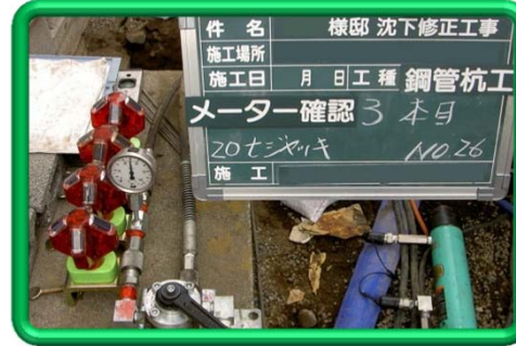
圧入の圧力メーター確認
