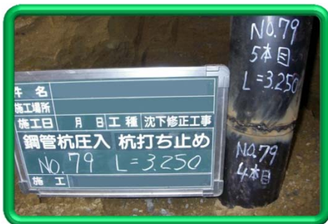
溶接した鋼管
