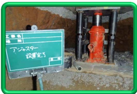
アジャスターとジャッキを設置
