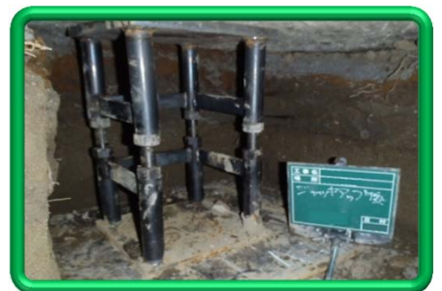
ジャッキアップ完了状況
