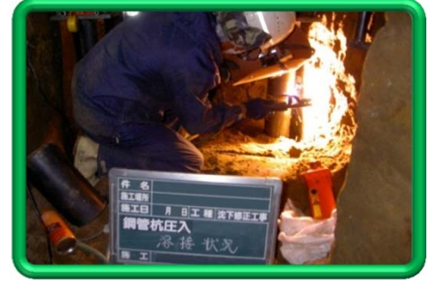
鋼管の溶接状況
