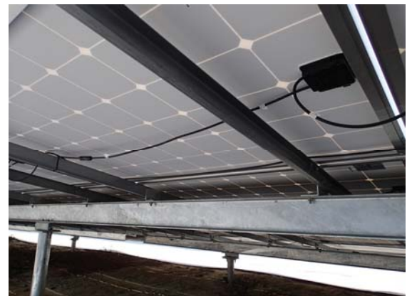
⑦ モジュール取付工(太陽電池の裏側)
