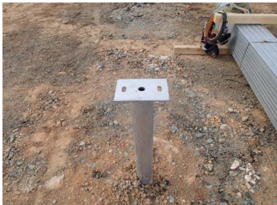
④ 杭材の建込完了
