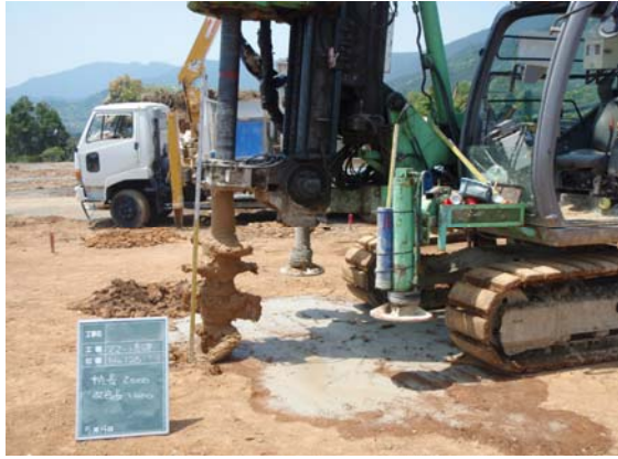
① 柱状改良打設工
