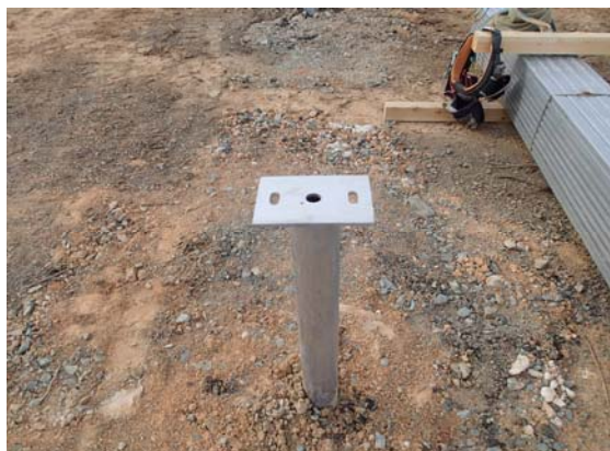
④ 杭材の建込完了
