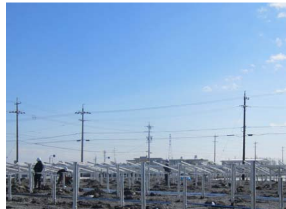
⑦ 架台組立工及びモジュール取付工
