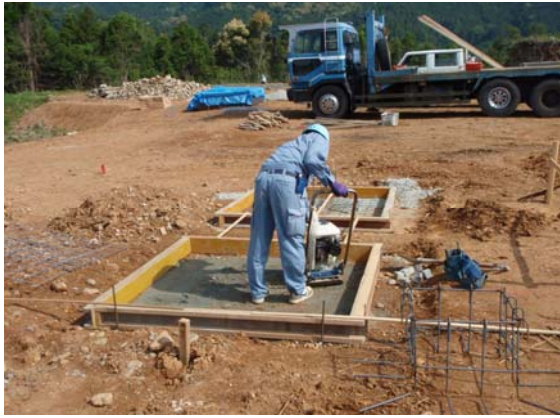
① 碎石転圧・型枠設置工
