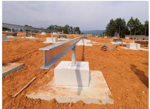
⑥ 架台組立工(梁材取付)
