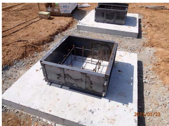
④ 基礎立上り型枠設置工
