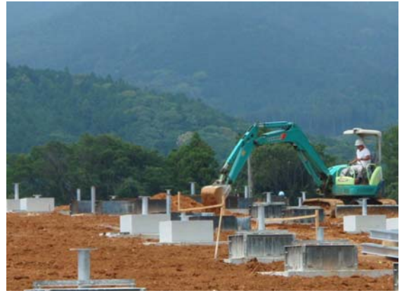
⑤ 柱材設置・型枠脱型
