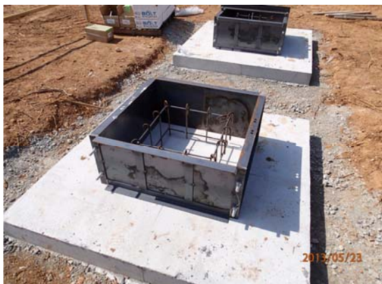
④ 基礎立上り型枠設置工
