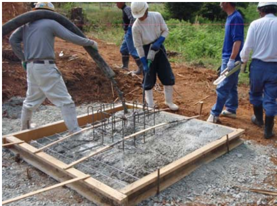
③ ベースコンクリート打設工
