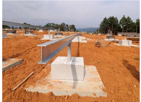
⑥ 架台組立工(梁材取付)
