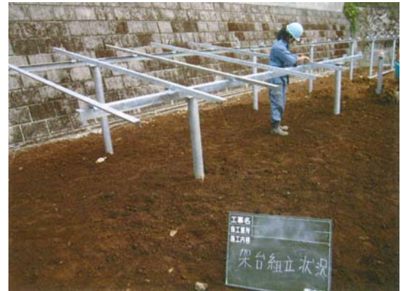
⑥ 架台組立工
