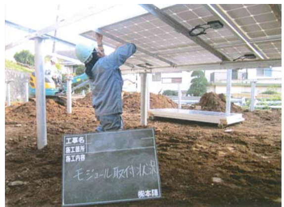
⑦ モジュール取付工
