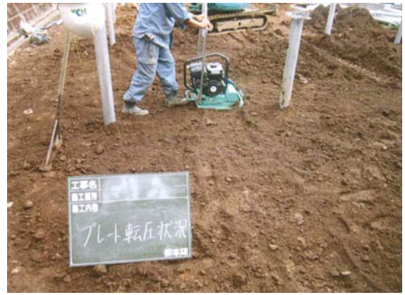
⑤ 転圧工 (土の埋め戻し)
