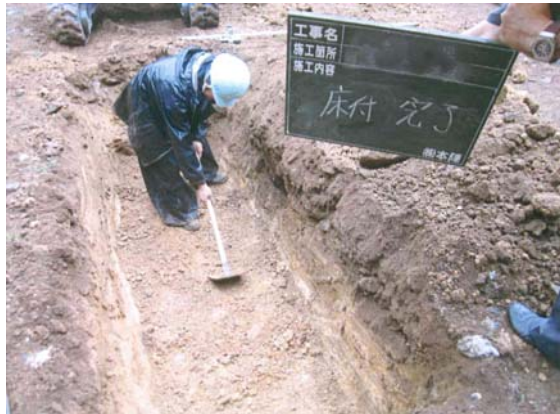
② 床付工 (鉄板式基礎の埋設準備)
