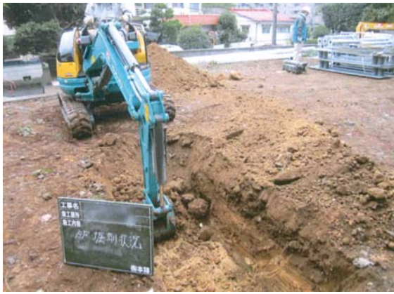
① 掘削工 (鉄板式基礎の埋設準備)
