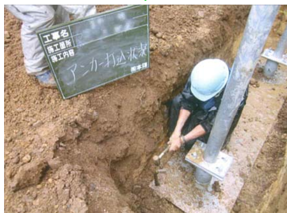
④ アンカー打設工 (鉄板式基礎の固定)
