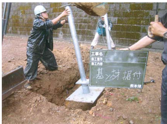
③ 据付工 (鉄板式基礎の埋設)
